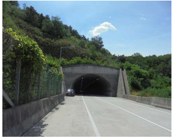
5공구 불로터널(상주) (5공구) 종점부
