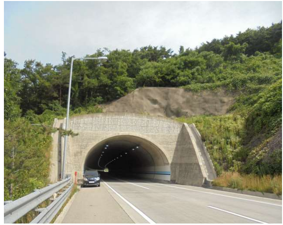
4공구 산법터널(영천방향) (4공구) 종점부
