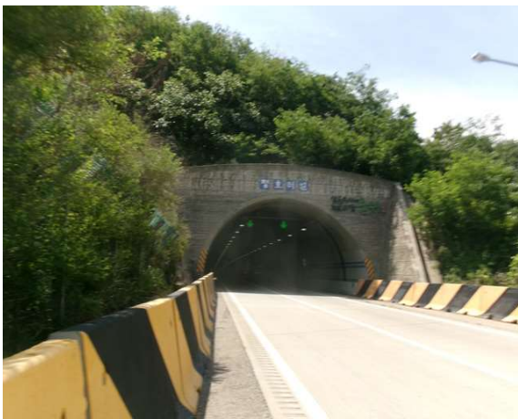
4공구 평호터널(영천방향) (4공구) 시점부
