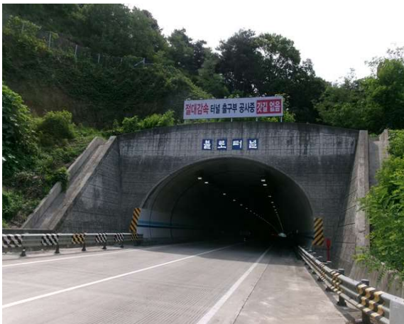
5공구 불로터널(영천) (5공구) 시점부
