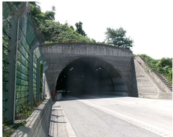
4공구 평호터널(상주방향) (4공구) 종점부
