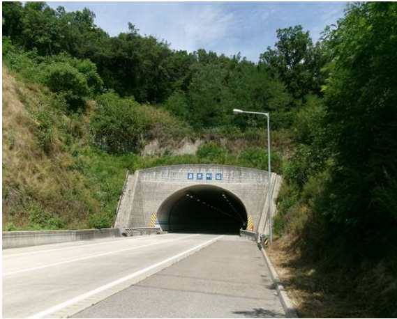
5공구 불로터널(상주) (5공구) 시점부
