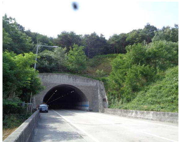
5공구 효령터널(상주방향) (5공구) 종점부
