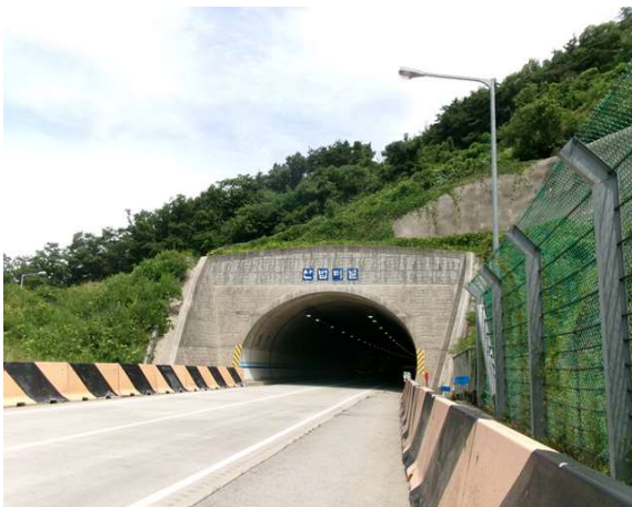
4공구 산법터널(상주방향) (4공구) 시점부
