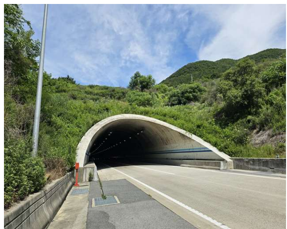
3공구 군위터널(영천방향) (3공구) 종점부
