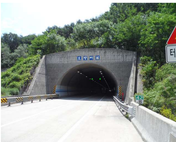
5공구 효령터널(영천방향) (5공구) 시점부
