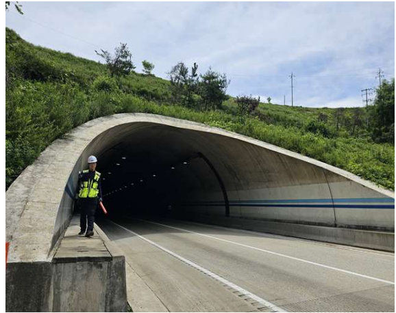
3공구 군위터널(상주방향) (3공구) 종점부
