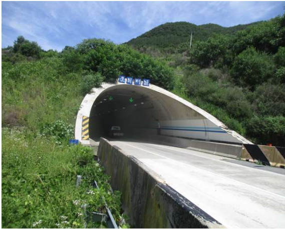
3공구 군위터널(상주방향) (3공구) 시점부
