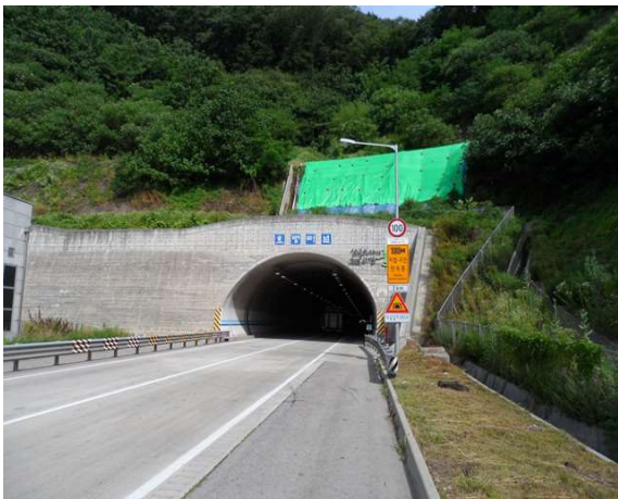
5공구 효령터널(상주방향) (5공구) 시점부
