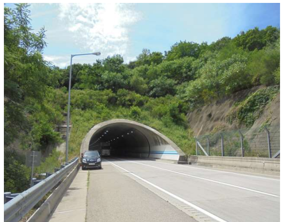
4공구 산법터널(상주방향) (4공구) 종점부
