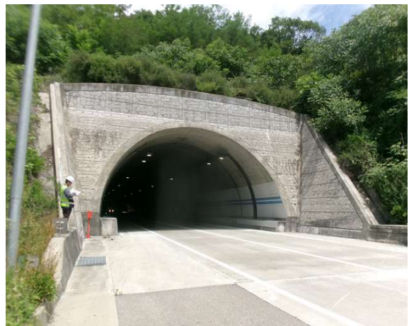
4공구 평호터널(영천방향) (4공구) 종점부
