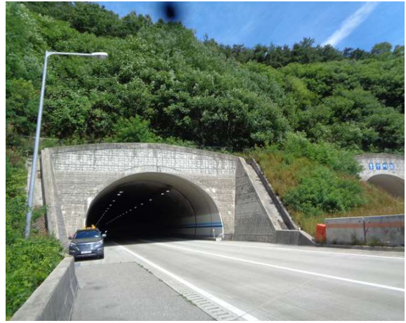
5공구 중구터널(영천) (5공구) 종점부
