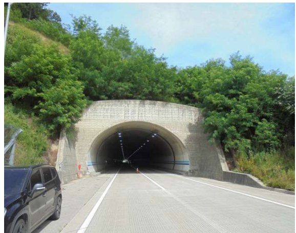
5공구 불로터널(영천) (5공구) 종점부
