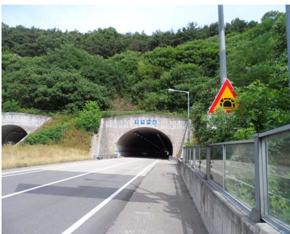
5공구 중구터널(상주) (5공구) 시점부
