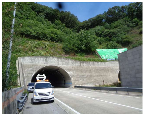
5공구 효령터널(영천방향) (5공구) 종점부
