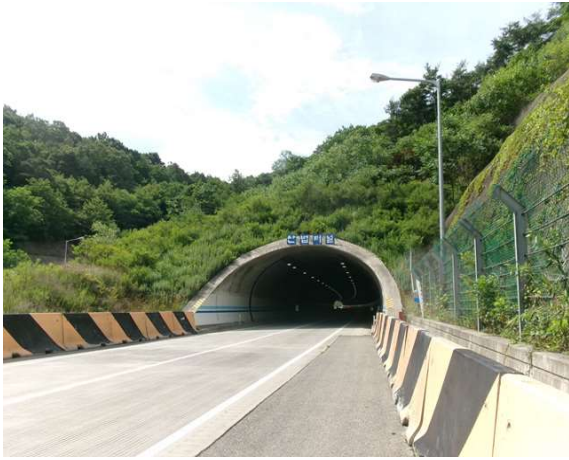
4공구 산법터널(영천방향) (4공구) 시점부
