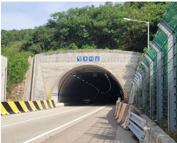
4공구 평호터널(상주방향) (4공구) 시점부
