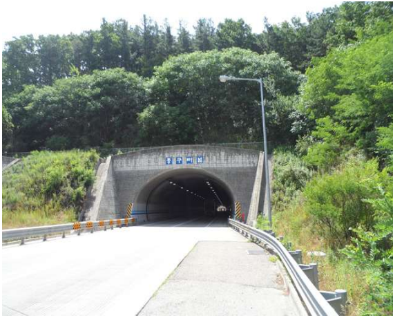
5공구 중구터널(영천) (5공구) 시점부
